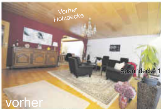
Vorher: Wohnzimmer mit Styroporplatten in Holzoptik. Die Decken waren gut erhalten und konnten somit als Unterkonstruktion wiederverwendet werden.
