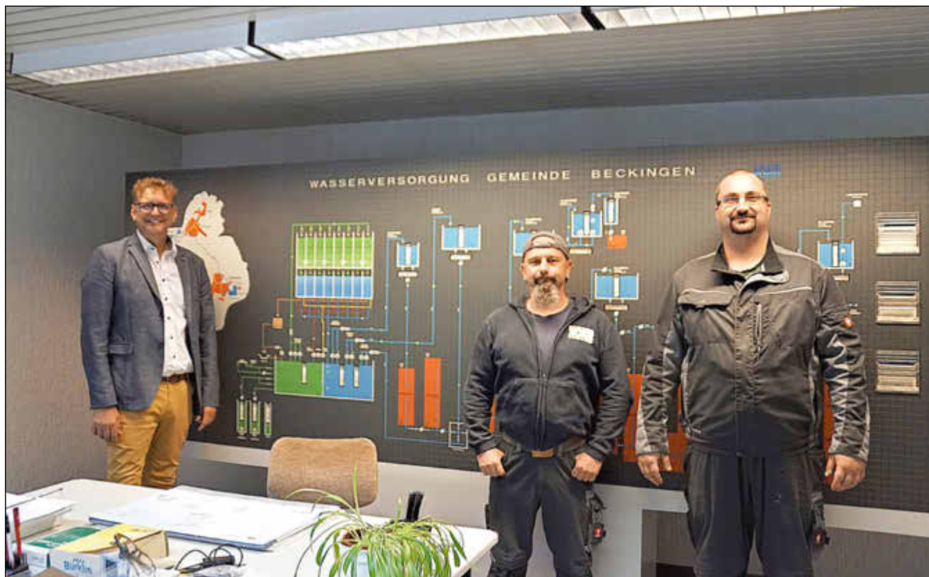
Bürgermeister Thomas Collmann (links) mit dem Mitarbeiter-Team Ralf Spath (Mitte) und Bernhard Schäfer (rechts) vor der großen Kontrolltafel in der Leitwarte des Wasserwerks in Hargarten
