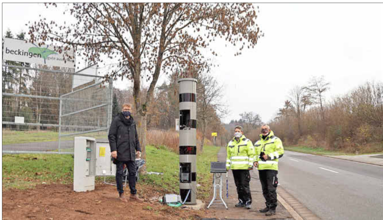
Bürgermeister Thomas Collmann informiert sich vor Ort über die Montage der Geschwindigkeitsmessgeräte
