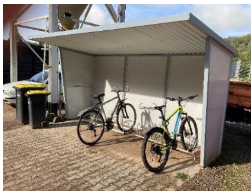
Abb. 44 Abstellanlage am Bauhof
