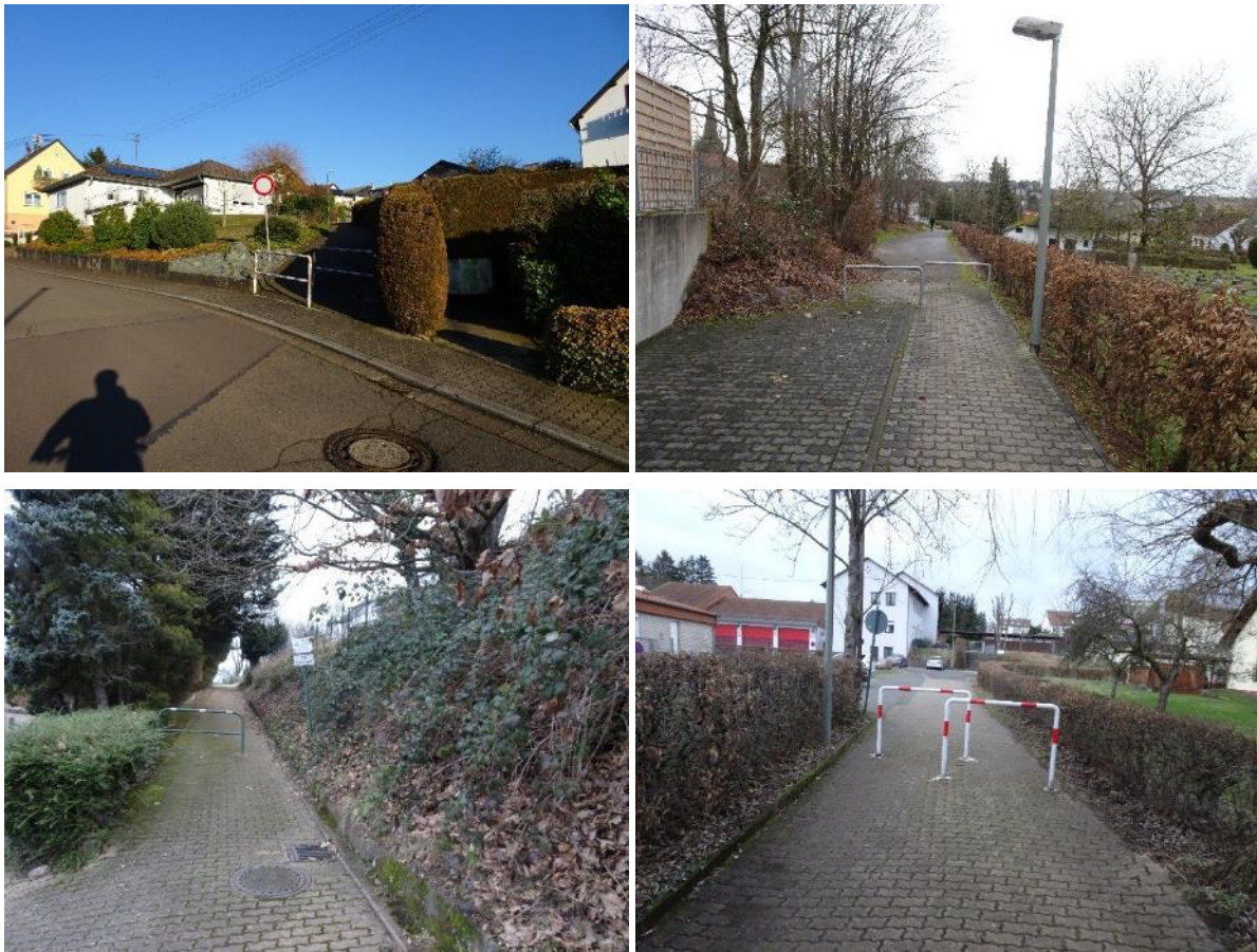
Abb. 35 Absperrungen als unnötige Hindernisse für den Radverkehr
