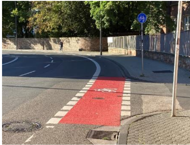
Abb. 10 Radfahrstreifen mit Rotmarkierung im Einmündungsbereich
