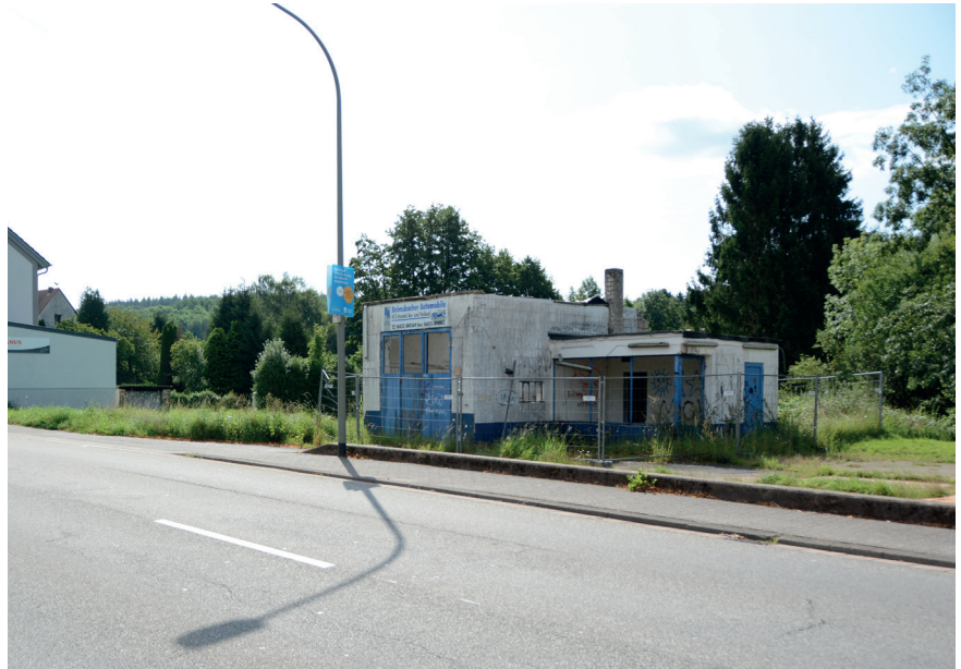
Marodes Gebäude der ehem. Tankstelle
