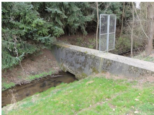
Abbildung 7: Staumauer bei Gewässer-km 1,7 oberhalb Brücke am Köpfchen
