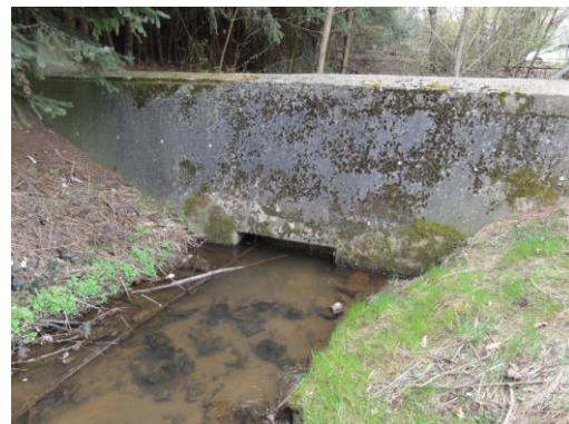
Abbildung 8: Staumauer bei Gewässer-km 1,7 oberhalb Brücke am Köpfchen
