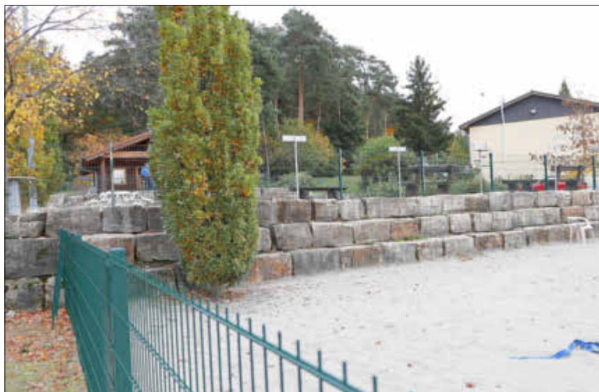
Blick auf die untere Stützmauer des Bouleplatzes.
