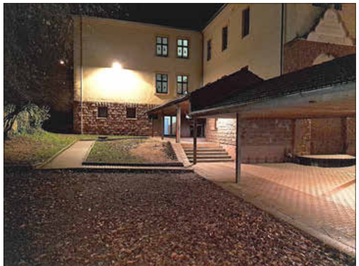
Einer dieser Brennpunkte ist der Schulhof der Grundschule in Beckingen und hier besonders der Bereich der überdachten, aber sonst offenen Pausenhalle mit einer Glastür als Zugang zum hinteren Bereich des dortigen Schulgebäudes sowie einem Vorraum auf der gegenüberliegenden Seite dieser Glastür für diverse Gegenstände wie Putzutensilien für die Reinigungskraft.
