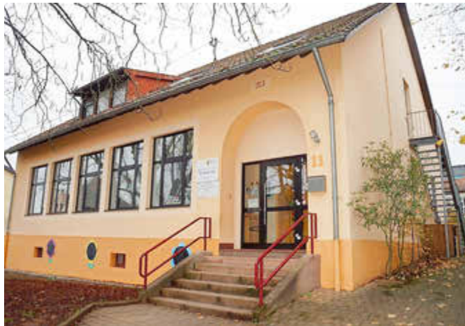
Das Gebäude der Kita St. Marzellus vor dem Abriss
