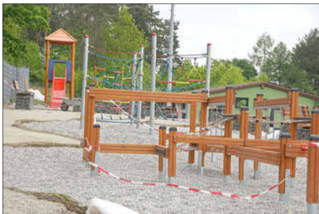
Blick auf derzeit bereits installierte Einrichtungen des entstehenden Motorikparks
