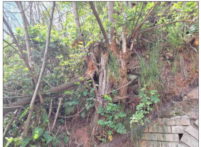
Stockfäule mit ausgebrochenem Stamm
